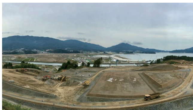
高台整備中の今泉地区高台。標高 130m の山を 50m まで削って整備した。(2016.9.24 撮影)
